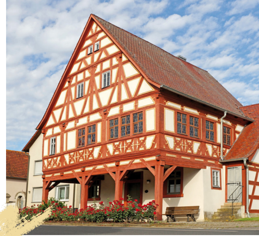
Die Fachwerkfassade des alten Rathauses in Dürrfeld ist mit genasteten Feuerböcken und verzierten Streben reichlich geschmückt. Das kräftige fränkische Rot des Fachwerks bildet farbenprächtige Kontraste zu den hellen Gefachen.
